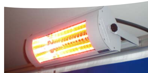
Heizstrahler Solamagic, befestigt in der Vario-Nut
