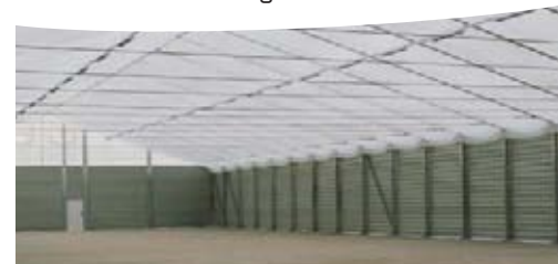
Innendachplanen gegen Abtropfen von Kondenswasser - Lichtbänder von uns geliefert
