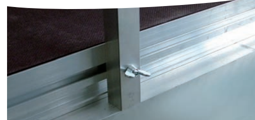
Bühnentreppe, Geländer und Bühnenblende werden direkt in der Profilvernietung befestigt
